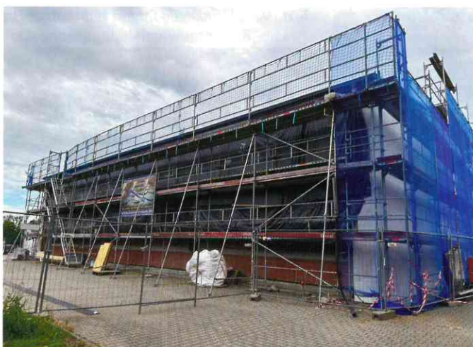
Umbaumaßnahmen brachten die Prüfungspläne durcheinander.
